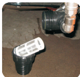
Frischwasserfilter leicht zugänglich
